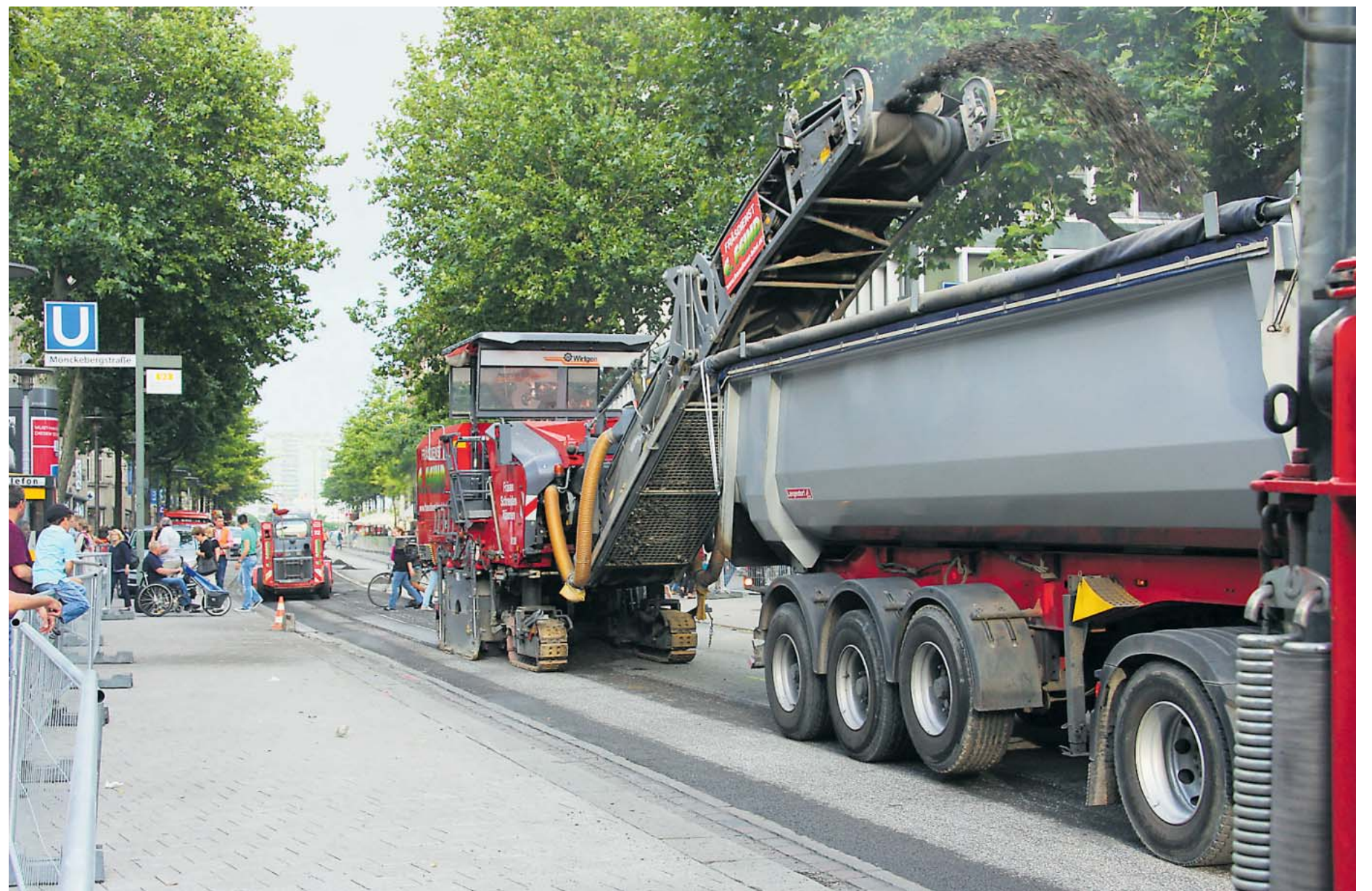
Das ging ganz schnell: Am Samstagvormittag wurde der Splittmastixasphalt der Mönckebergstraße in Hamburg abgefräst...
