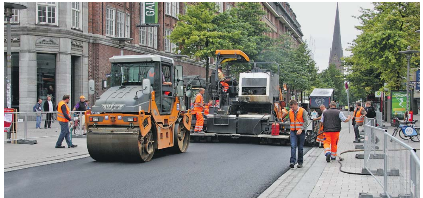
... im Mischwerk grundlegend aufgearbeitet und einen Tag später als vollwertiger Straßenbelag wieder eingebaut.
